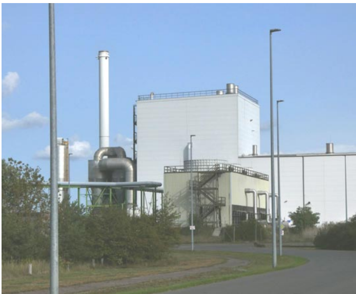
Holzkraftwerk Eberswalde: 100.000 Tonnen Frischholz werden hier jährlich verfeuert
