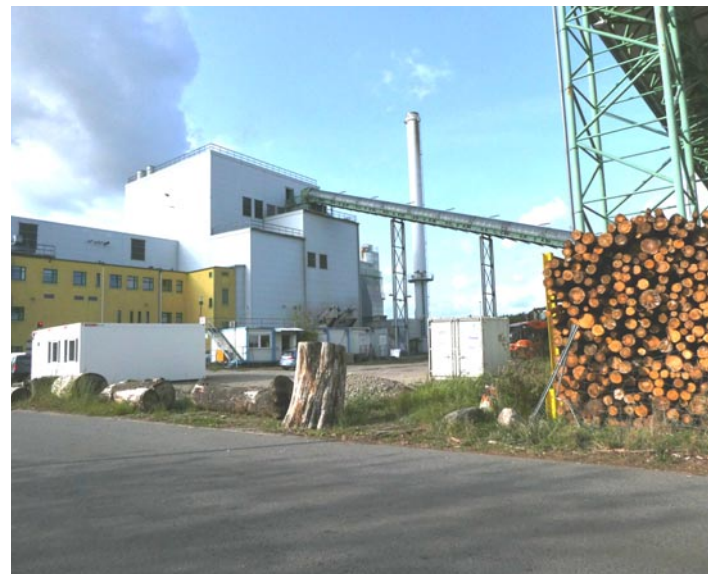
Holzkraftwerk Eberswalde: 100.000 Tonnen Frischholz werden hier jährlich verfeuert
